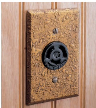
Los tomacorrientes de giro son diseñados para enchufes que se insertan y rotan. Una pequeña plaqueta al final de uno de los orificios evita que el enchufe se desconecte del tomacorriente.
