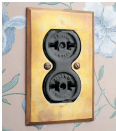
Este tomacorriente doble de cerámica tiene una forma única de reloj de arena. Es diseñado para 250 voltios pero sólo 5 amperios y no sería admitido para los códigos actuales.
