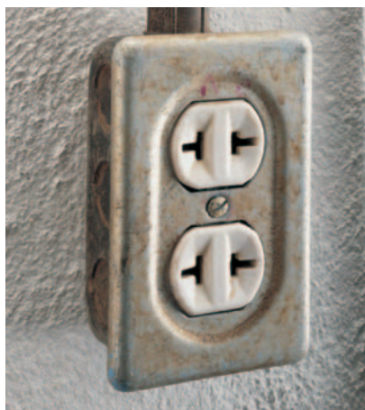
Los tomacorrientes dobles de cerámica fueron fabricados en los años 30. Son polarizados pero no a tierra y son conectados para 120 voltios.
