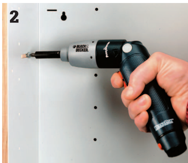
Use tornillos para madera (uno para cada orificio montante a los lados del centro de distribución) para sostener la caja. No los apriete por completo.
