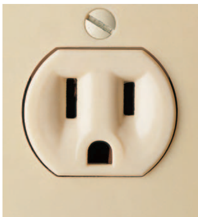
15 amperios y 120 voltios. El tomacorriente de tres entradas a tierra tiene dos tamaños diferentes de entradas y un orificio a tierra en forma de "U". Es requerido en toda nueva instalación eléctrica.
