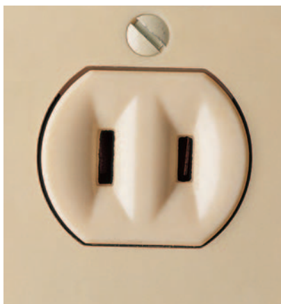
15 amperios y 120 voltios. El tomacorriente polarizado de dos entradas es común en casas construidas antes de 1960. Las entradas tienen diferentes tamaños para acomodar el enchufe polarizado.
