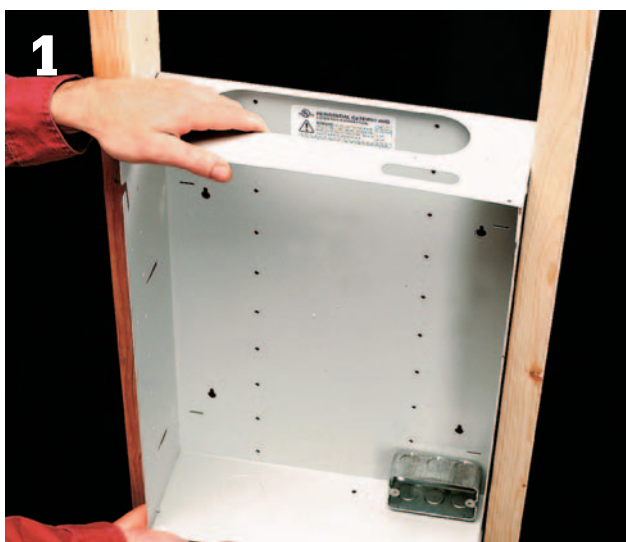
Instale un centro de distribución al menos 48" sobre el piso. Colóquelo entre dos montantes separados a 16" de distancia.
